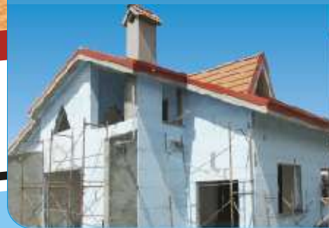
Κατοικία ΚΑΤΑ την εφαρμογή του Kelyfos
