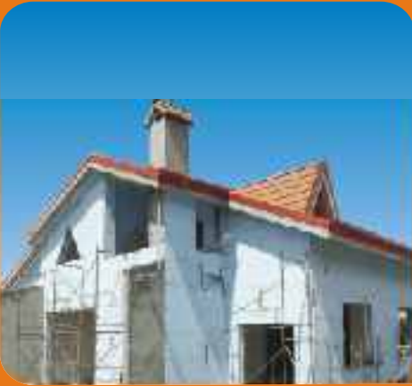
Κατοικία ΚΑΤΑ την εφαρμογή του Kelyfos
