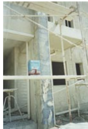
Εφαρμογή του REVINEX σε εξωτερικό σοβά ενισχυμένο με υαλοπλέγμα GAVAZZI
